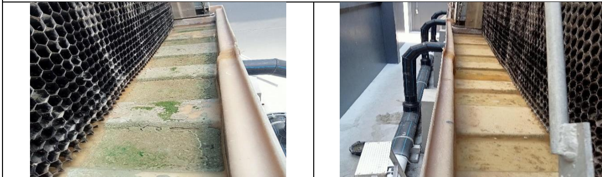
การทำความสะอาด Cooling Tower
